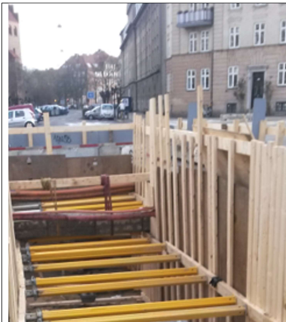
Figur 19 - Eksempel 4 fra HOFOR-projekt. Afstivning med jernplader og værn
