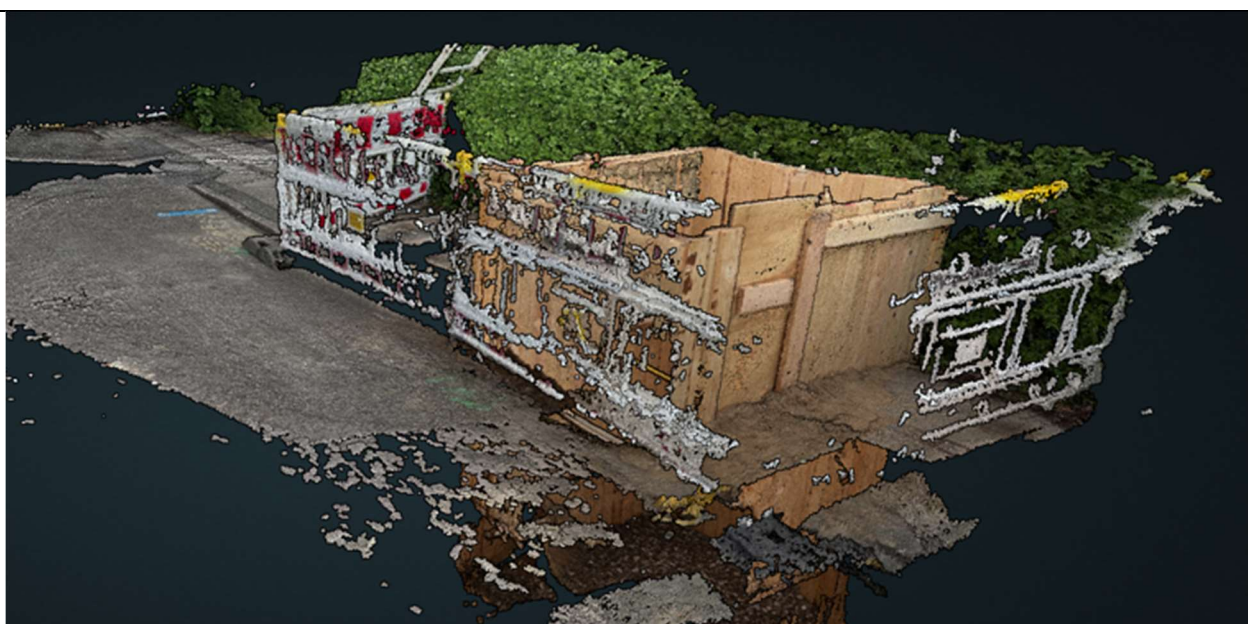
Figur 18 - Eksempel 3 fra HOFOR-projekt: Afstivning med træplader samt afspærringsmateriale
