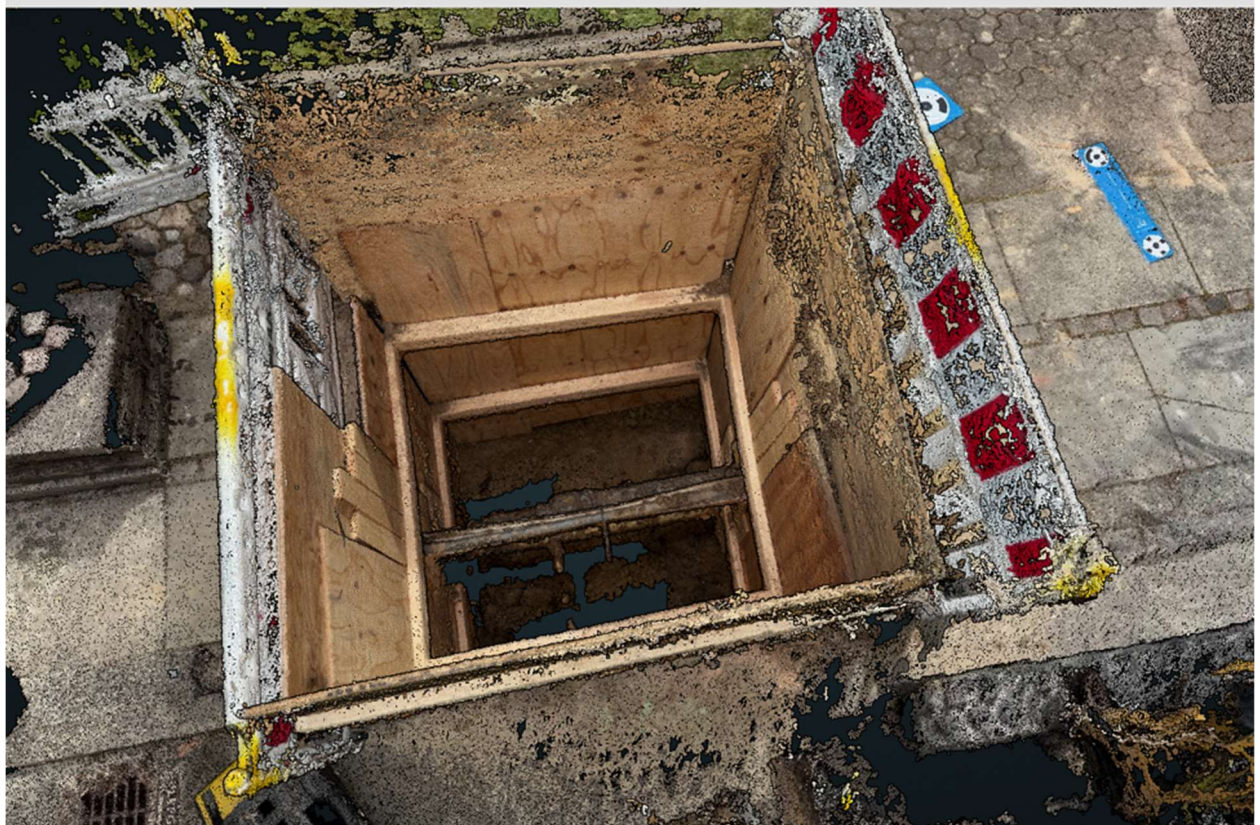
Figur 16 - Eksempel 1 fra HOFOR-projekt: Afstivning med træplader samt afspærringsmateriale
